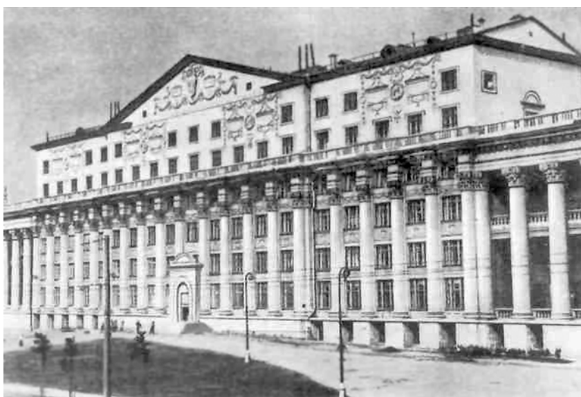
Здание на Академической улице, в котором разместился ИХПС
